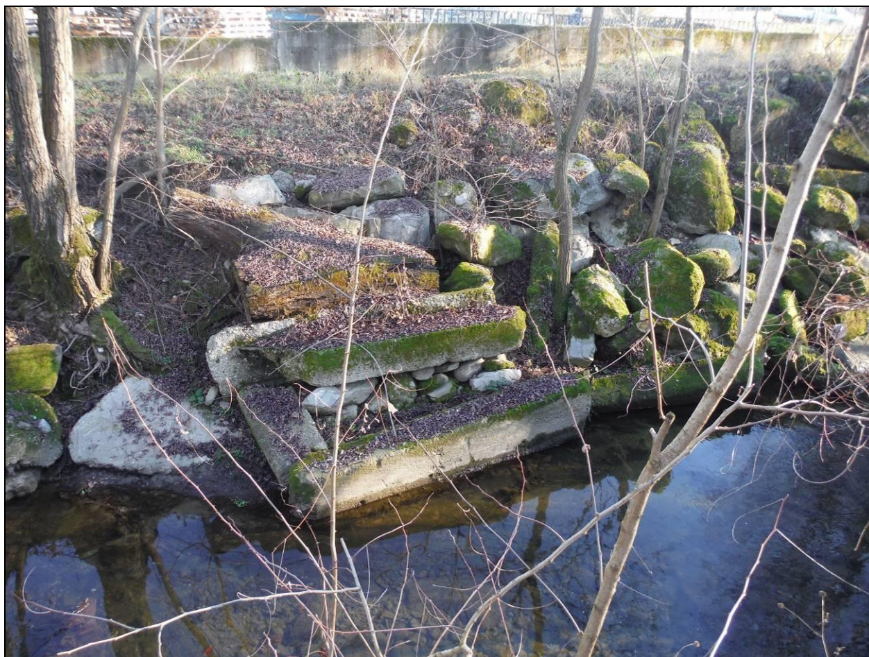
Figura 8 – Scogliera esistente in sponda destra, vista dalla sponda opposta
