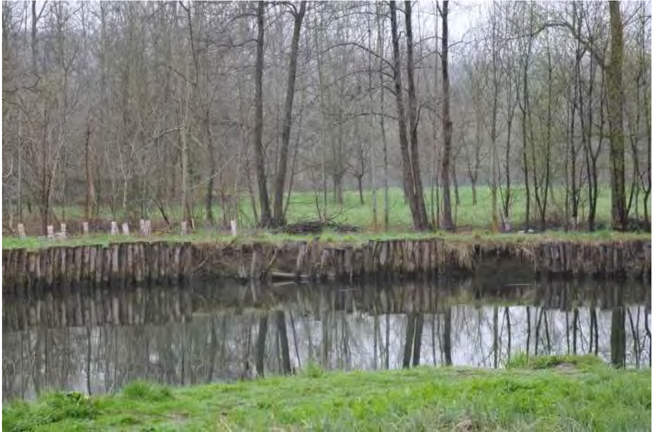
Difesa spondale destra in stato di degrado
