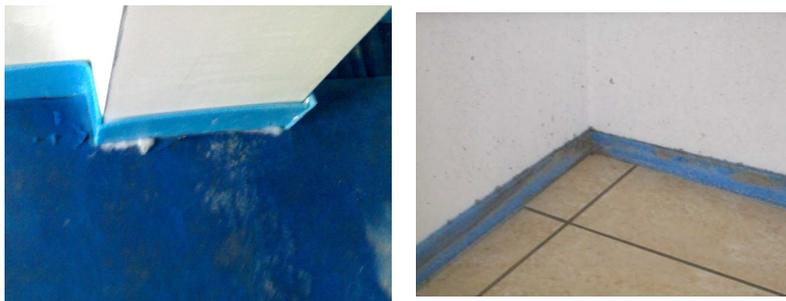
Figura 13: Corretto posizionamento fascia perimetrale
