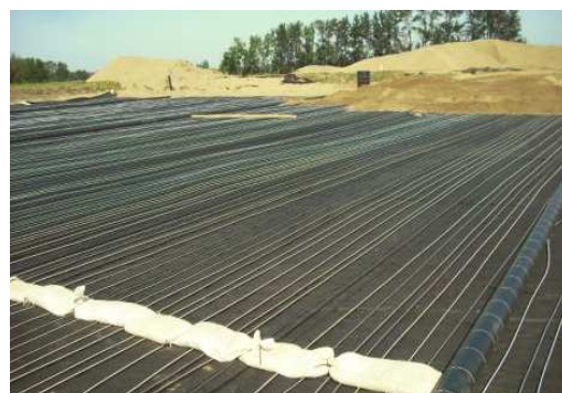
Figura 25 – Sistemi di fitodepurazione aerati (fonte: ARM ltd)
