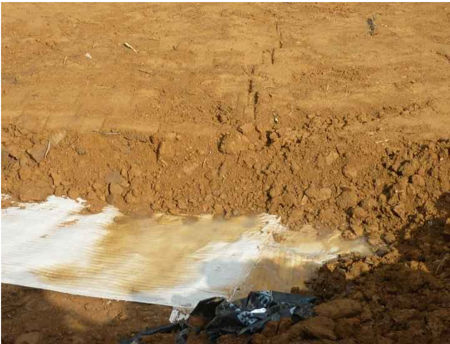
Esempi posa telo bentonitico
