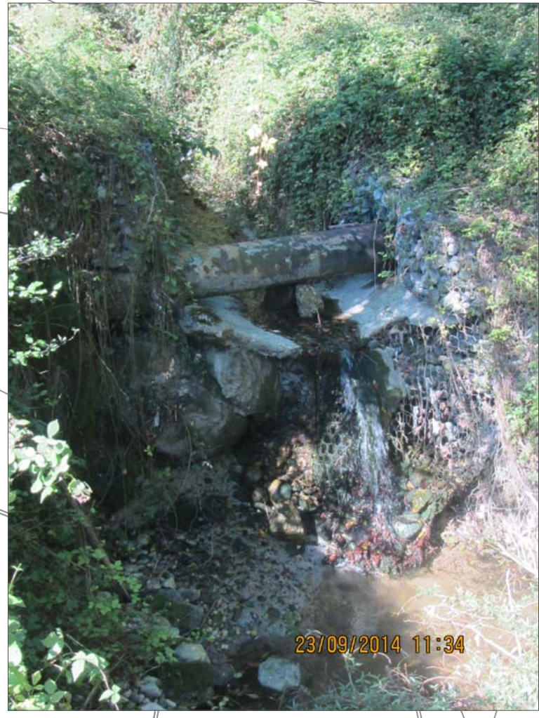
Foto 1: interferenza con rete di fognatura a gravità
