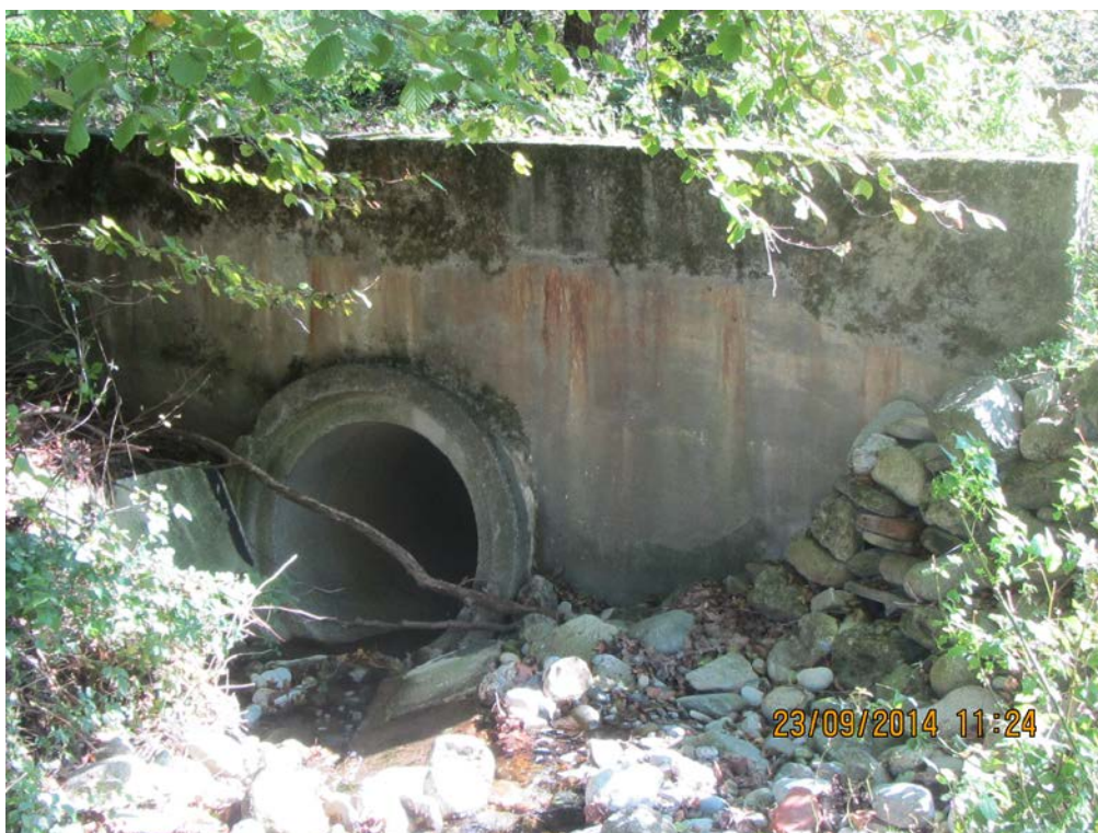
Figura 3 – Attraversamento posto sulla roggia nord, tubazione in calcestruzzo di diametro 1.0 m
