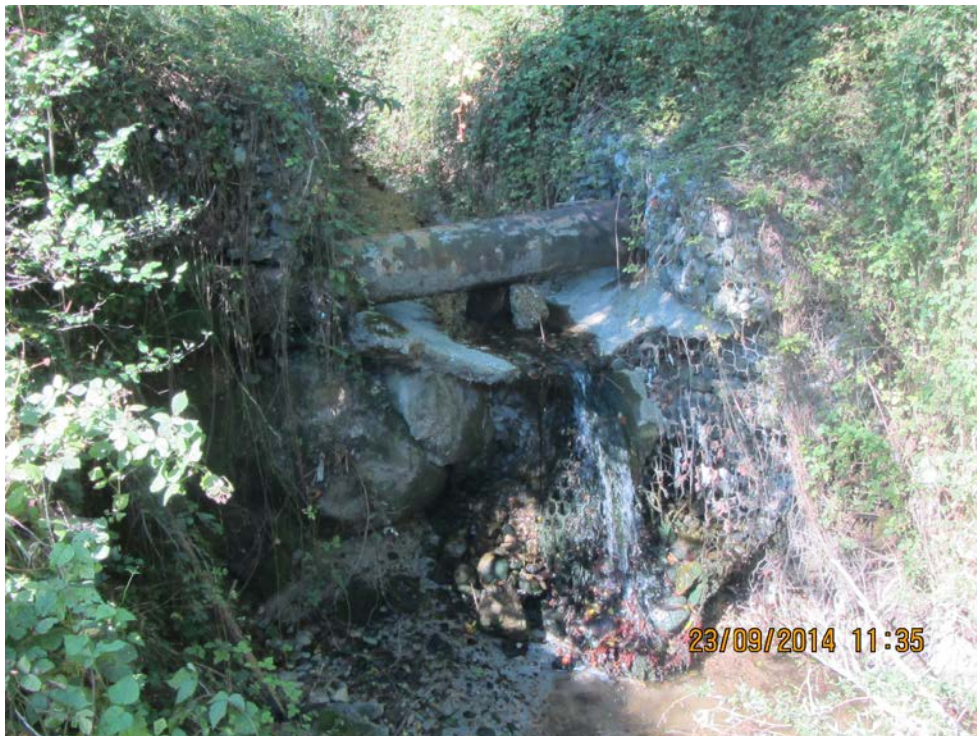
Figura 4 – Attraversamento della tubazione della fognatura, gabbionate danneggiate e salto di fondo
