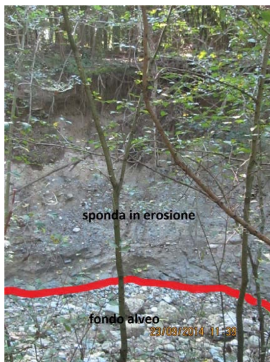
Figura 2 – Vista del fenomeno erosivo spondale
