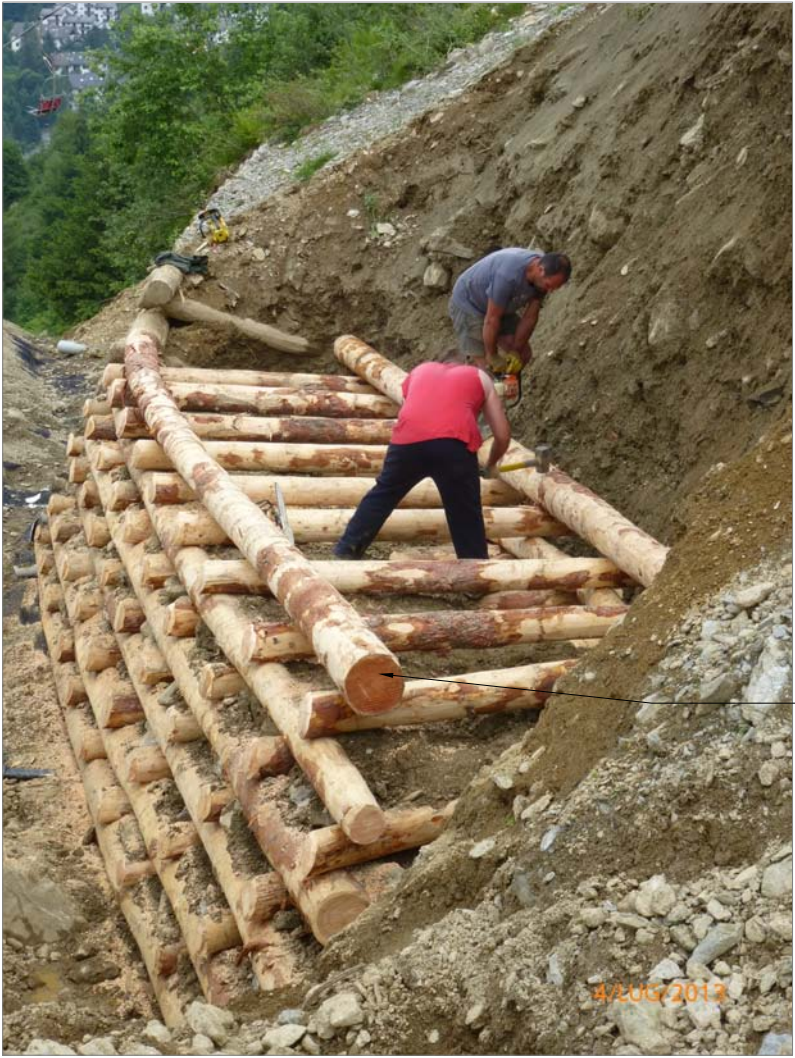
ESEMPIO DI ALLESTIMENTO DELLA PALIFICATA
