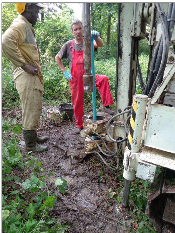
posa tubo piezometrico
