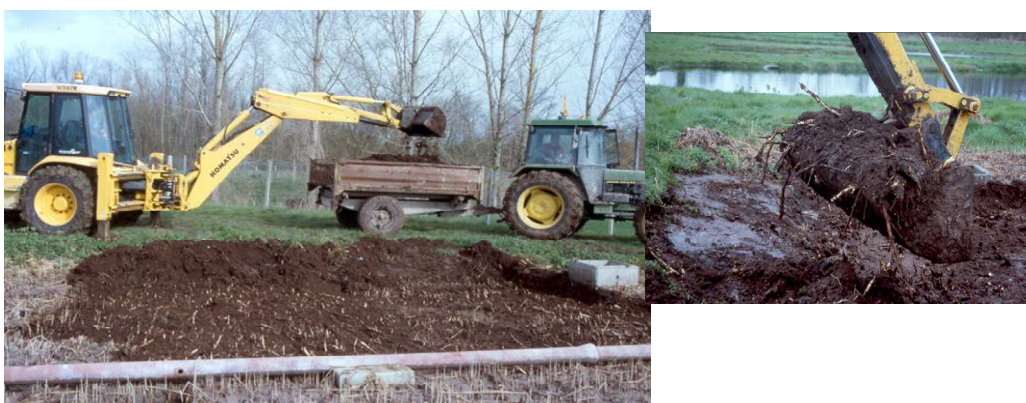
Operazioni di svuotamento dei letti con mezzi meccanici
