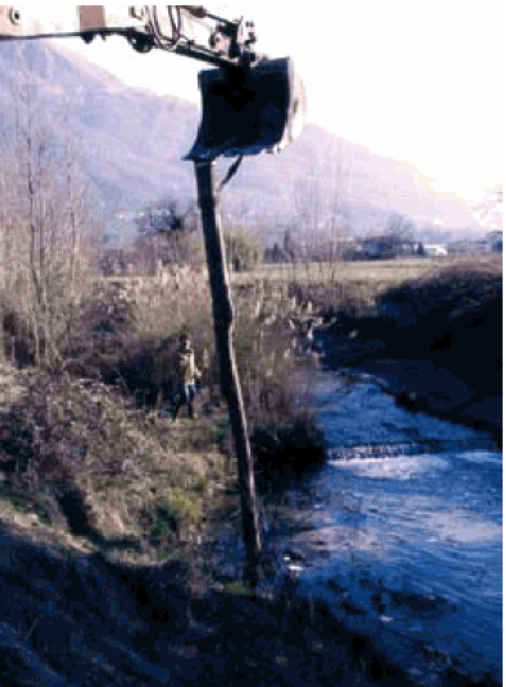
Esempio modalità di infissione dei pali all'interno del gabbione metallico
