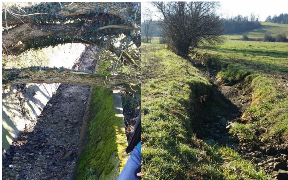
Canalizzazione del Rio Brovada nei pressi del centro sportivo di Besana in Brianza (sx) / tratto interamente naturale che attraversa i campi a valle (dx)
