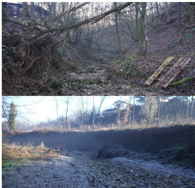
In alto sezione tipica del Torrente Brovada nel tratto a valle della briglia di consolidamento; In basso vista da valle della curva destrorsa del torrente in località Cascina Siberia, Comune di Triuggio
