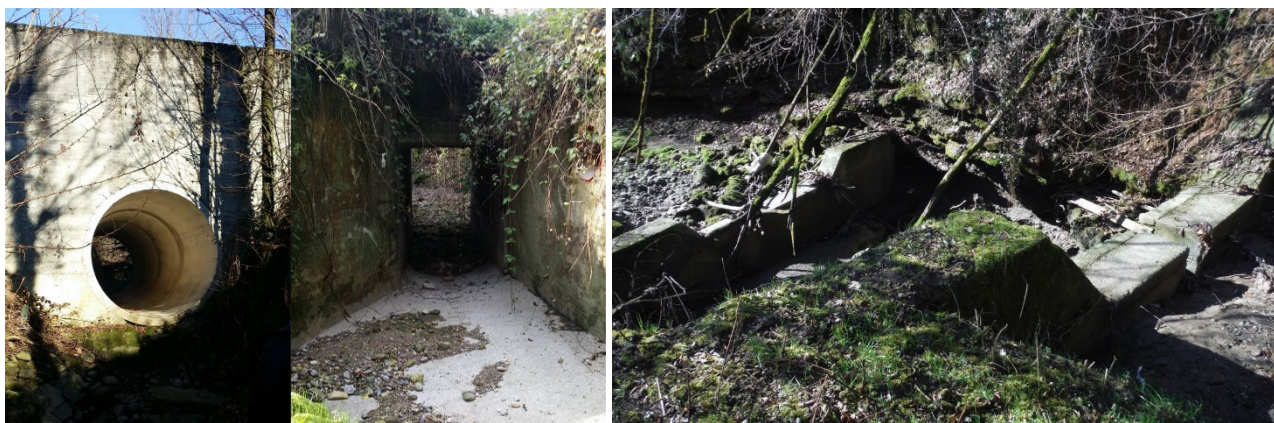
Attraversamento di Via Borromeo e vista da monte dell'attraversamento di Via della Valle / Briglia di consolidamento esistente all'altezza del cimitero della frazione Calò
