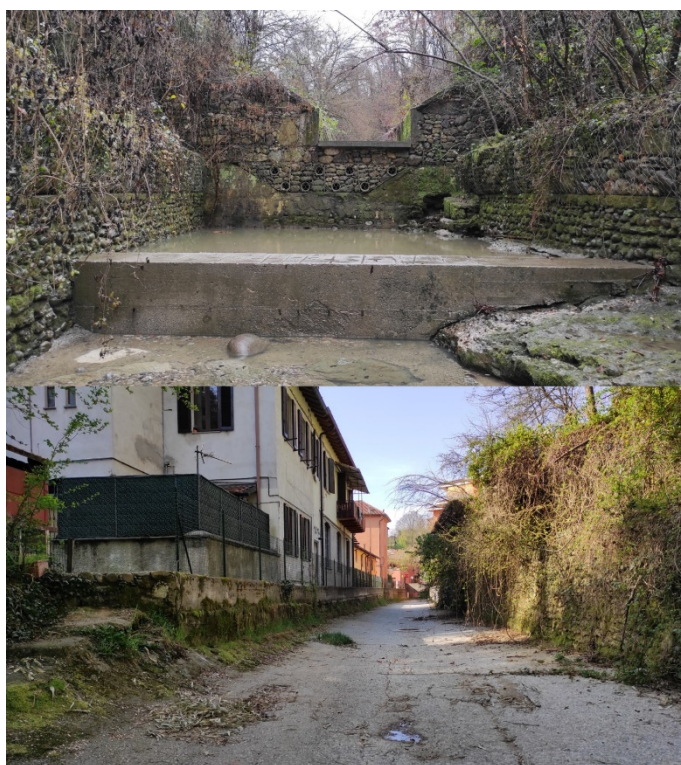
Briglia di consolidamento in gabbioni (in alto) a monte del tratto terminale dell'alveo, artificia lizzato in cls e muratura (in basso) all'interno della frazione di ponte Albiate
