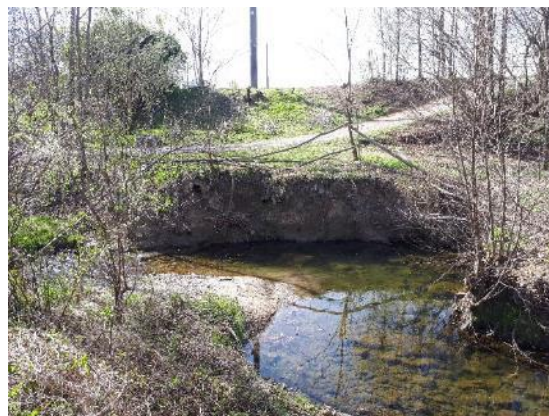
Figura 1-15 Criticità D2: Marcata erosione spondale in sinistra idrografica a valle del tratto protetto da scogliera
