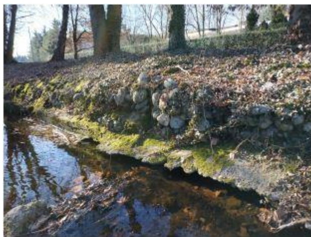
Figura 1-12 Criticità D1: Scalzamento al piede di una gabbionata realizzata a protezione di un collettore fognario
