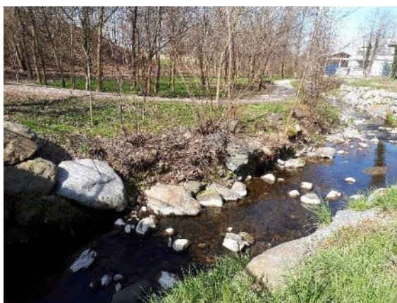
Figura 1-13 Criticità D2: Tratto di scogliera in parte collassata a valle di un attraversamento pedonale
