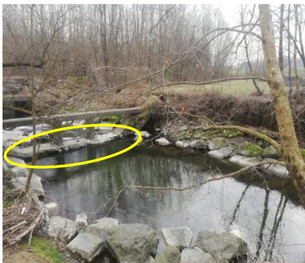
Figura 1-8 Criticità C1: Sponda sinistra della Bevere e opera trasversale soggetta a marcata erosione. In giallo è evidenziata l'instabilità alla base della briglia.
