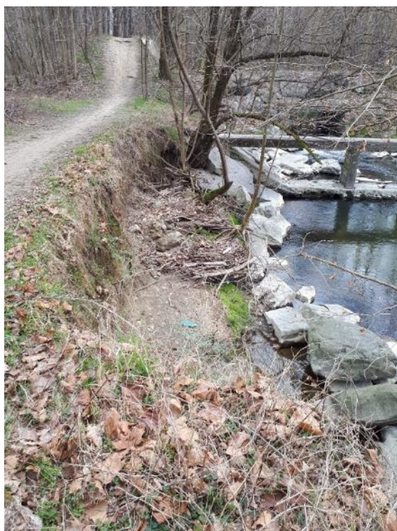
Figura 1-9 Criticità C1: Sponda destra del torrente a valle dell'opera trasversale interessata dalla presenza di piante e significativamente erosa.
