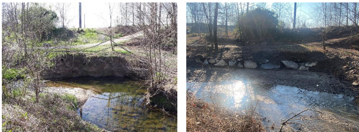
Figura 14: Realizzazione sponda - intervento D2.4 a) prima e b) dopo i lavori
