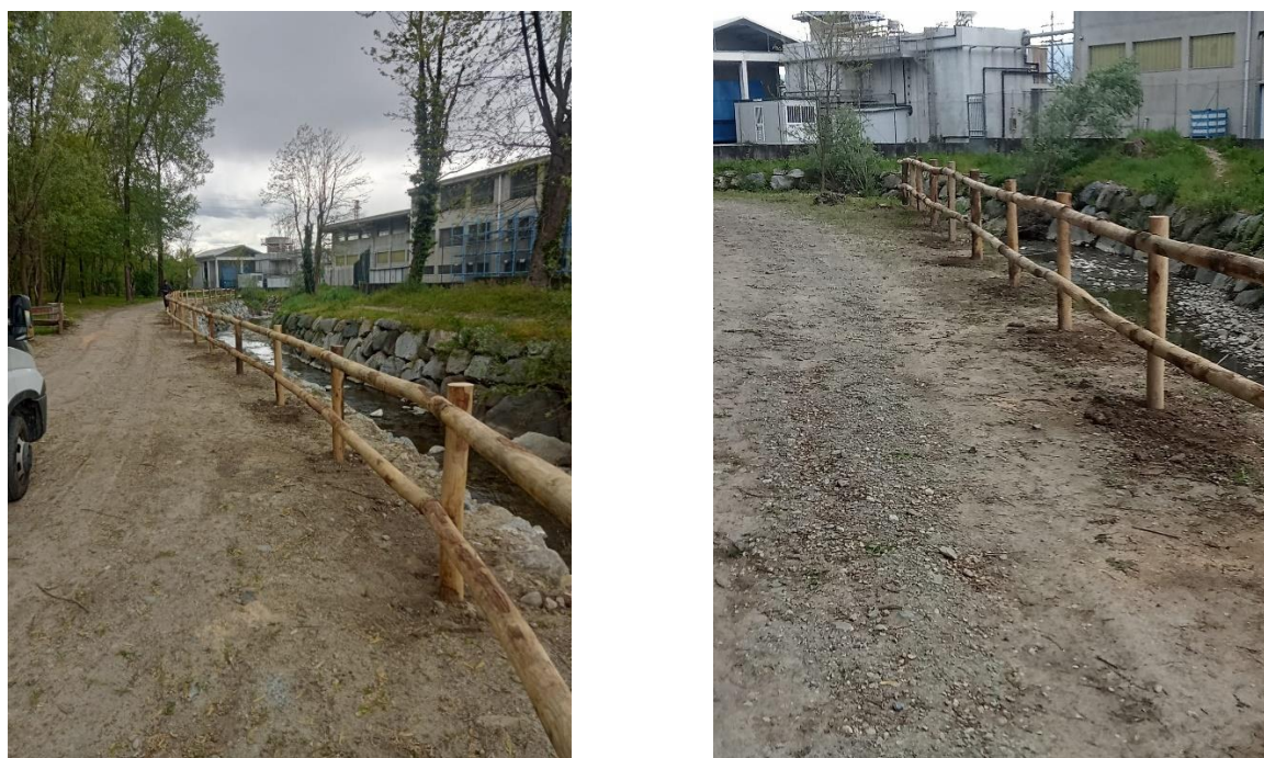
Figura 13: Completamento recinzione lungo sponda della Bevera - intervento D2.3 dopo i lavori
