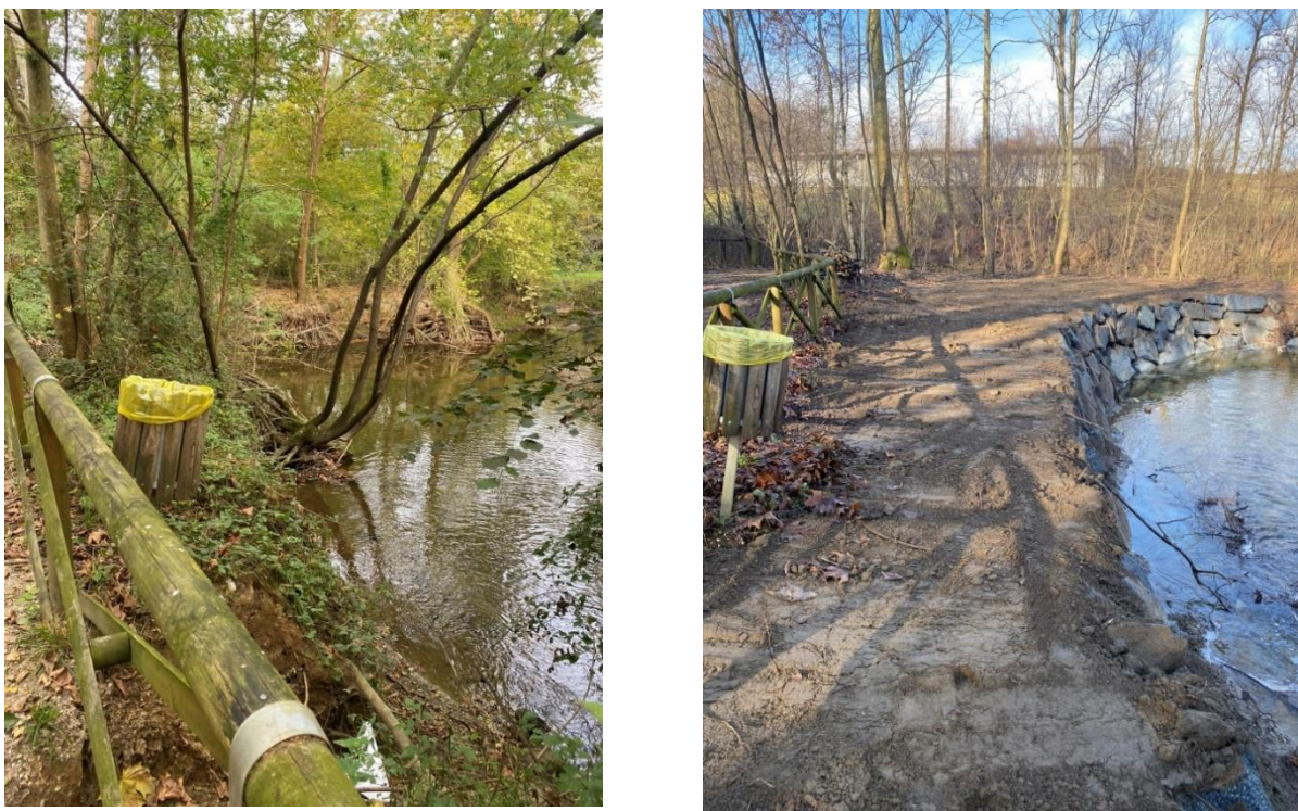
Figura 2: realizzazione scogliera - intervento B1 a) prima e b) dopo i lavori
