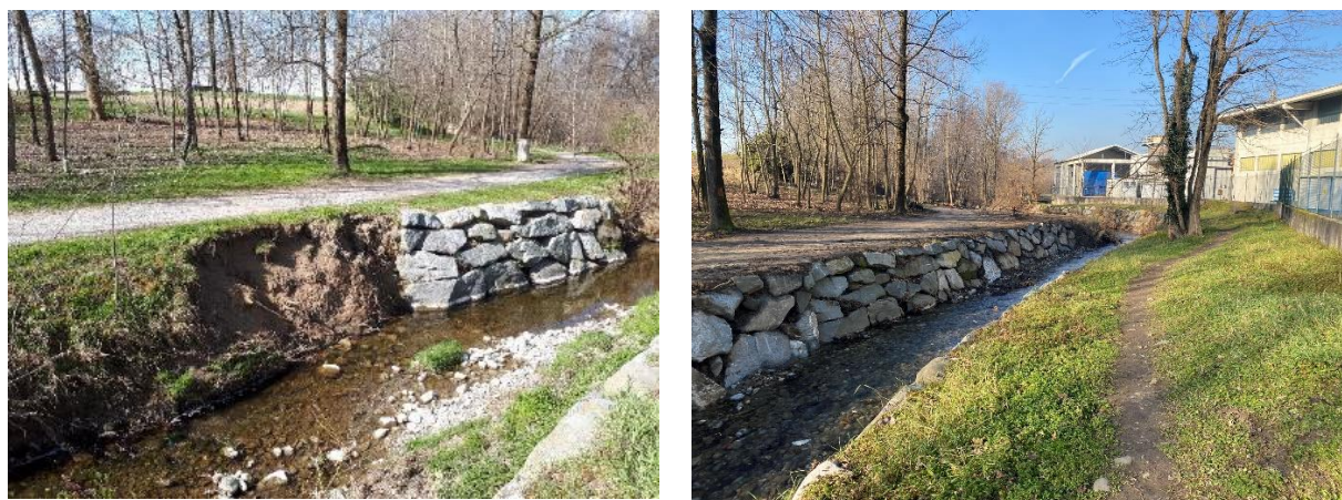
Figura 11: Completamento sponda a monte di quella esistente - intervento D2.2 a) prima e b) dopo i lavori
