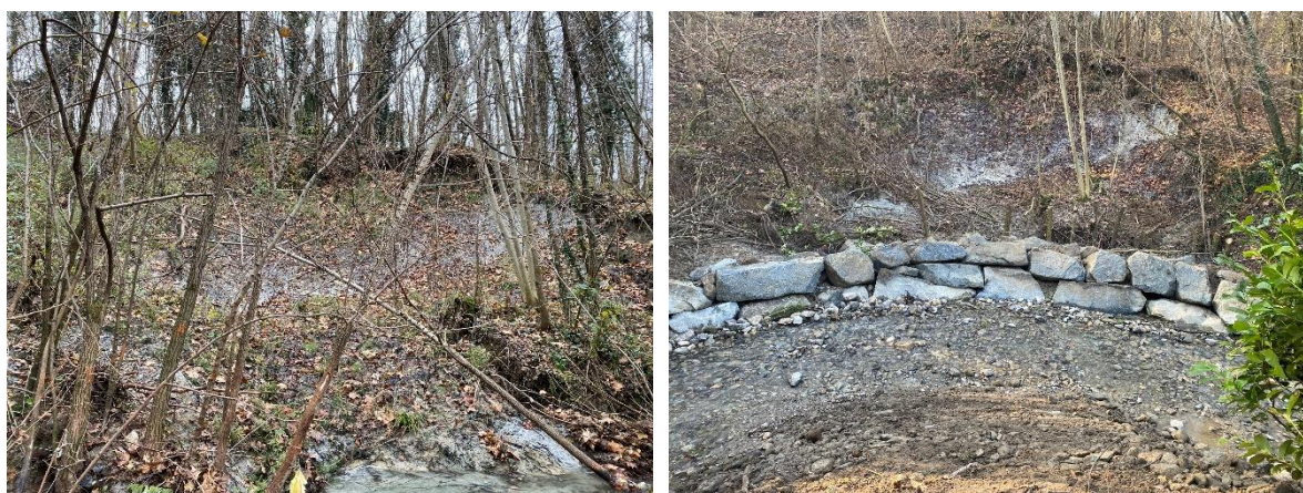
Figura 17: realizzazione scogliera - intervento E1.2 a) prima e b) dopo i lavori
