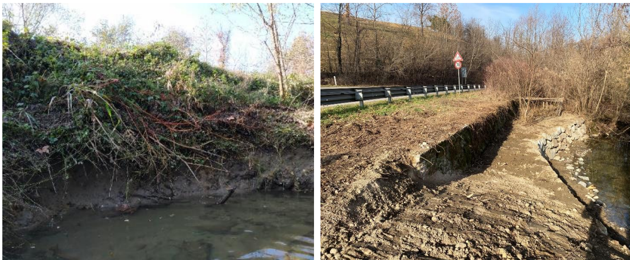
Figura 1: realizzazione scogliera - intervento A1 a) prima e b) dopo i lavori
