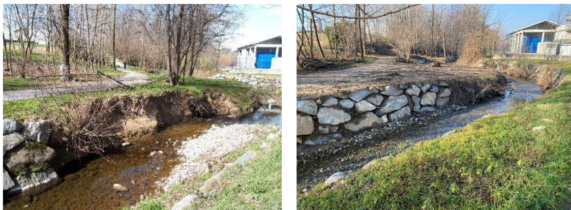
Figura 12: Completamento sponda a valle di quella esistente - intervento D2.3 a) prima e b) dopo i lavori
