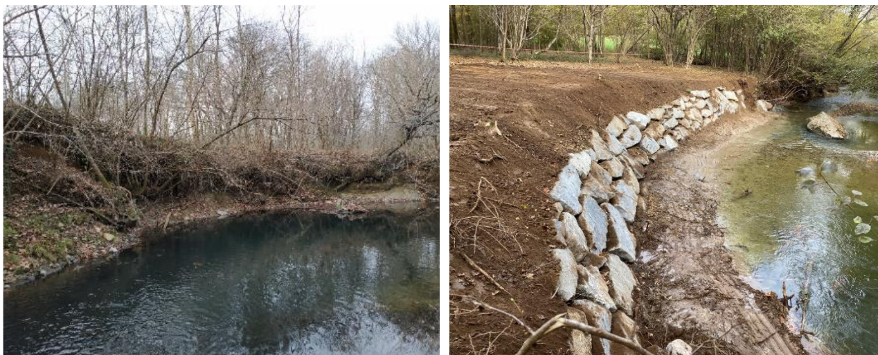
Figura 3: realizzazione scogliera - intervento B2 a) prima e b) dopo i lavori
