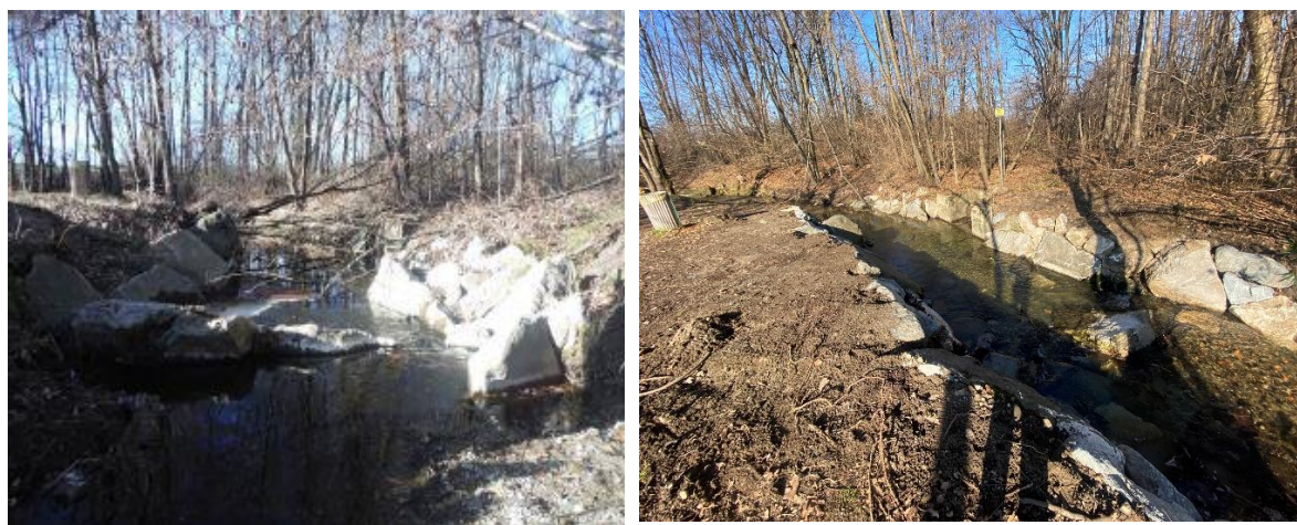
Figura 15: Sistemazioni sponde esistenti e creazione selciato - intervento D3 a) prima e b) dopo i lavori
