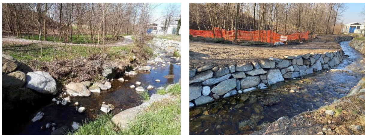
Figura 10: sistemazione sponda esistente a valle del ponte - intervento D2.1 a) prima e b) dopo i lavori
