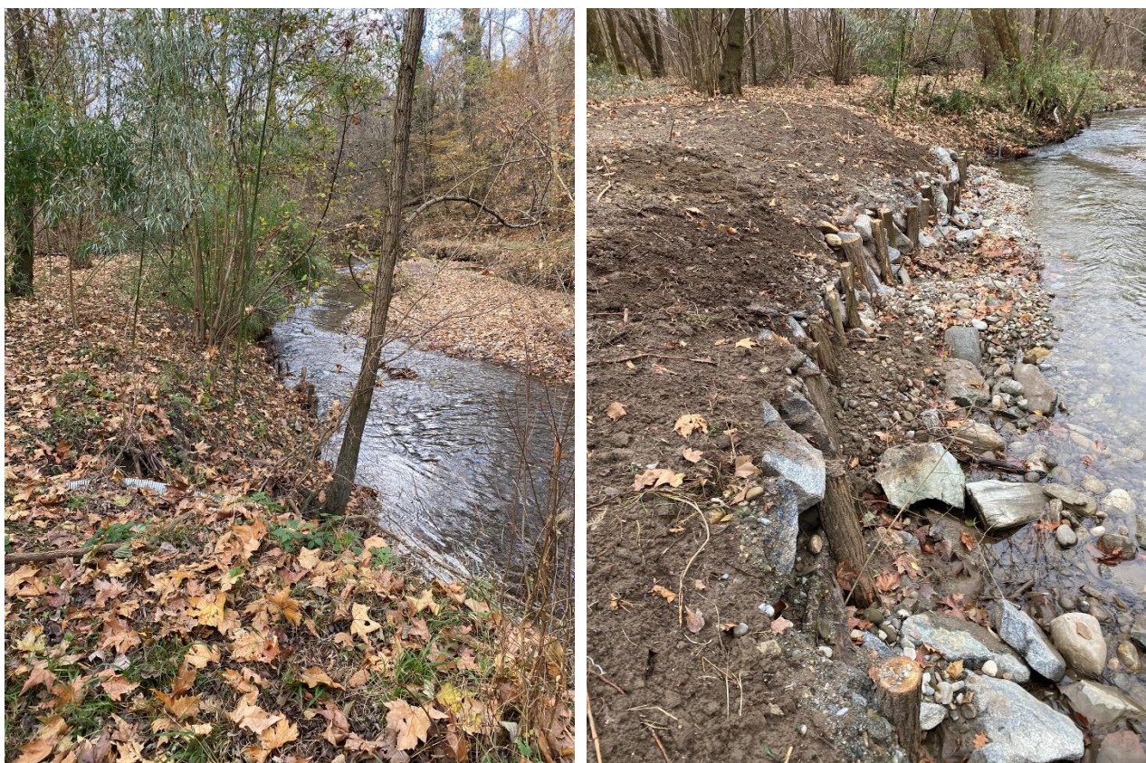
Figura 5: sistemazione palificata esistente - intervento B4 a) prima e b) dopo i lavori
