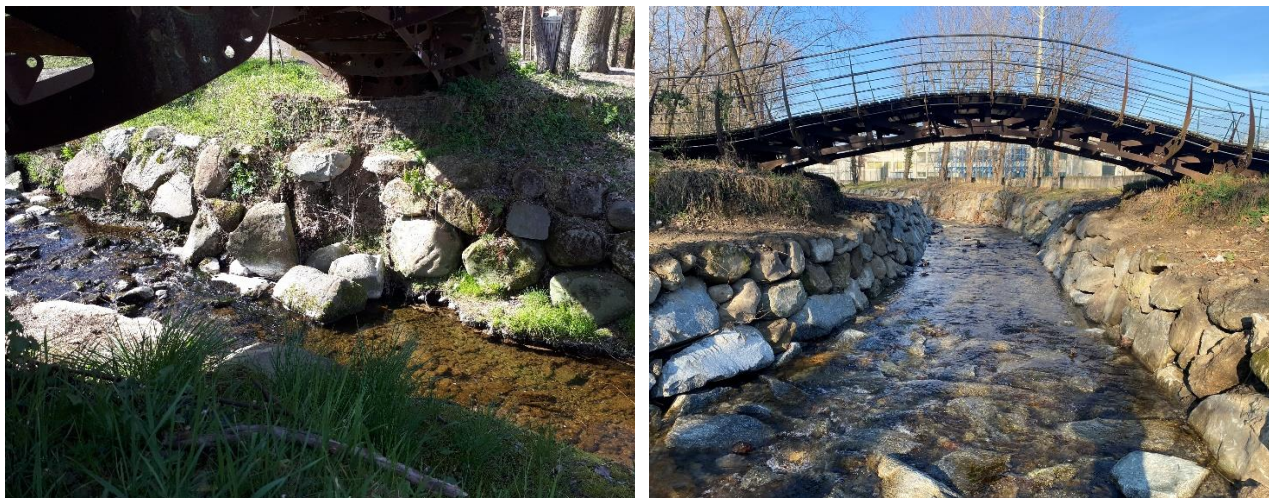
Figura 9: sistemazione sponde esistenti sotto il ponte e creazione selciato di fondo - intervento D2.1 a) prima e b) dopo i lavori
